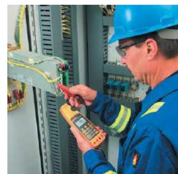
Misura di processo e altri segnali di automazione 4-20 mA senza "interruzione del loop"
